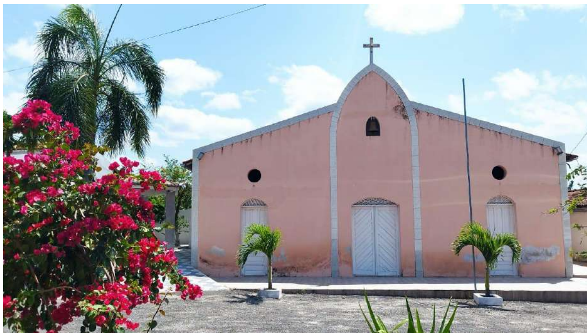
Figura 31. Capela Nossa Senhora da Conceição
