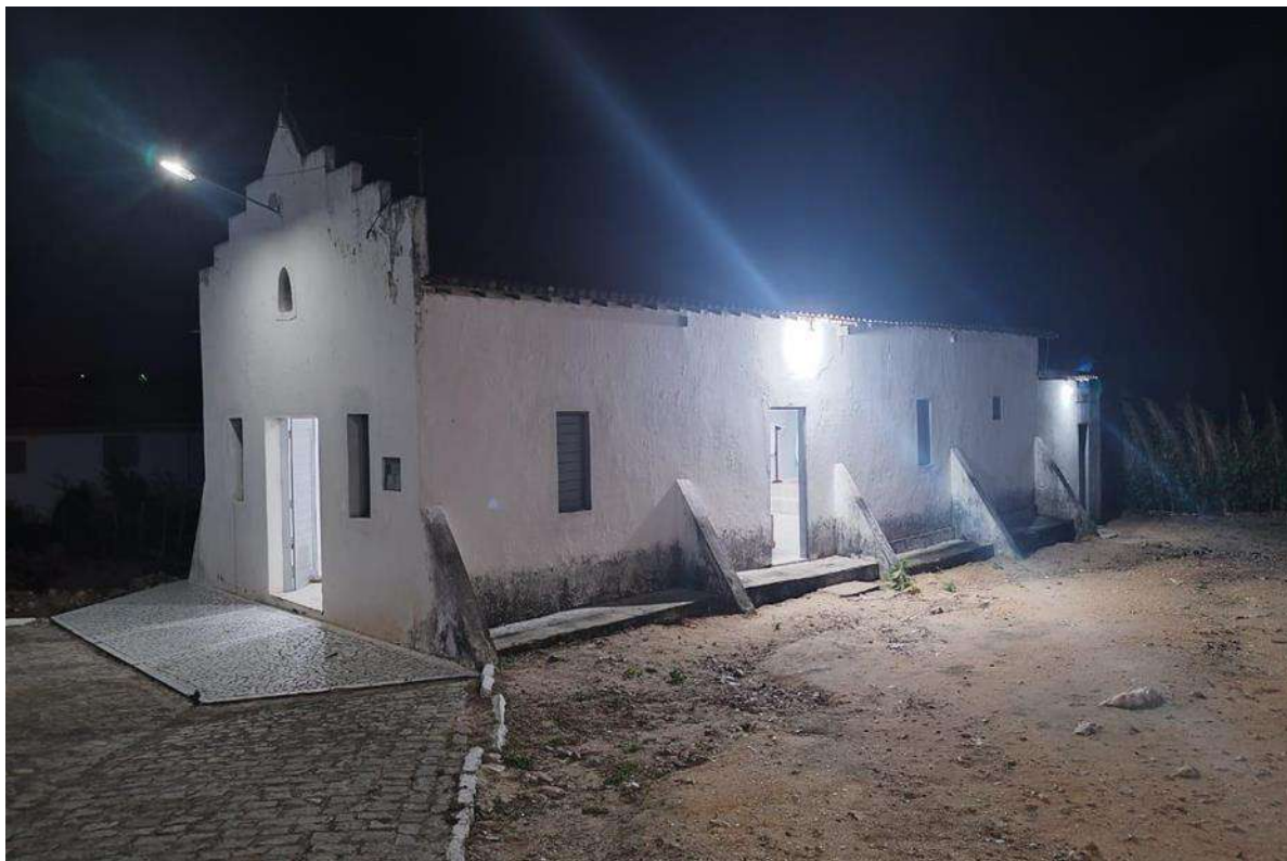
Figura 20. Capela Nossa Senhora da Guia
